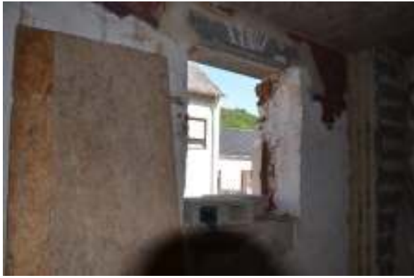
Außenwand mit Fensteröffnung
