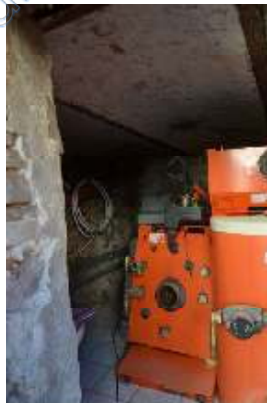
Heizungsraum mit demontierter Heizung
