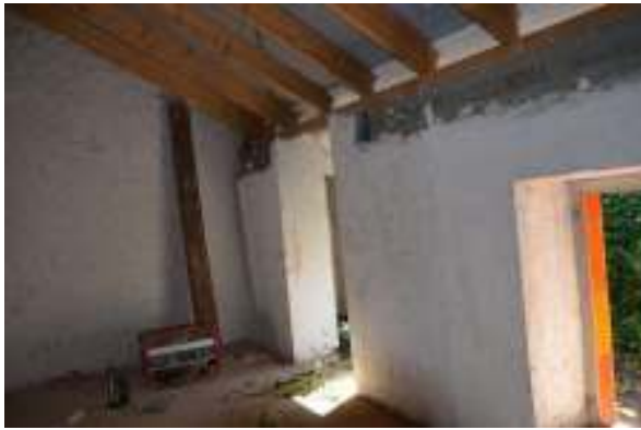
Außenwände Wohnung Nr. 2
