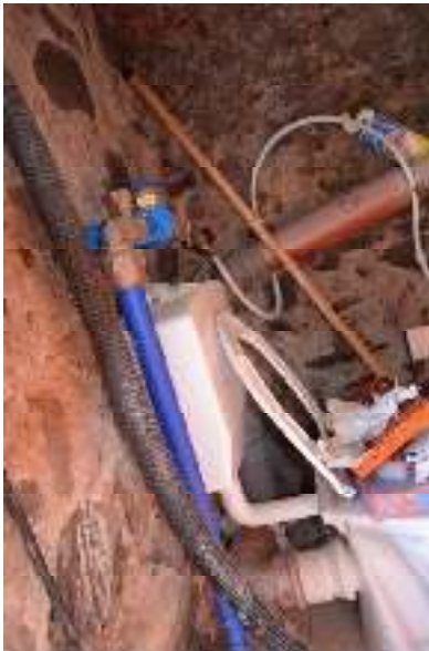
WC im Kellerraum
