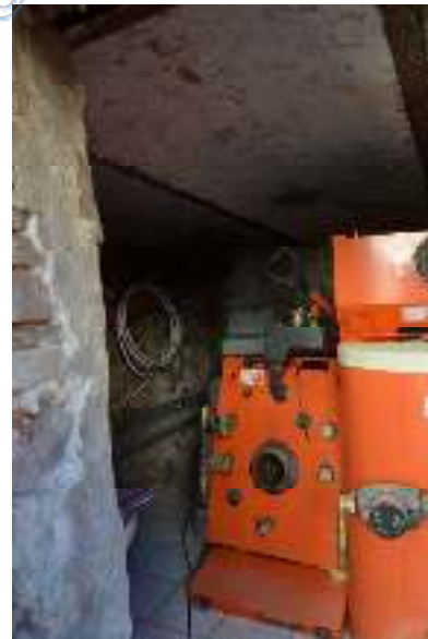
Heizungsraum mit demontierter Heizung
