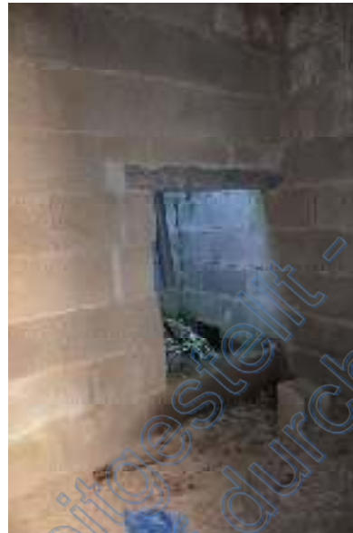
Öffnung zum Lichtschacht in Küche in Bodenhöhe
