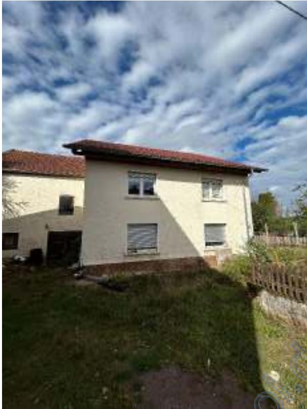
Gebäudefront (von der Friedhofsstr.)
