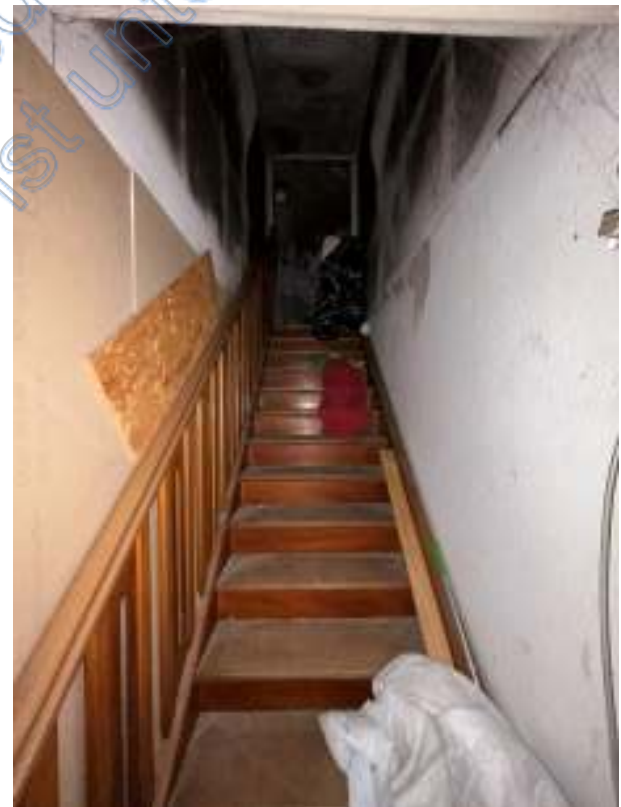
Treppe zum Dachraum
