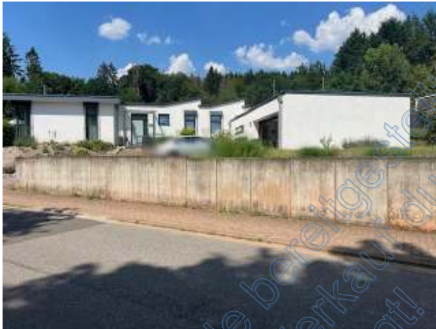
Bild 1: Ansicht des Bewertungsobjekts aus südlicher Richtung
