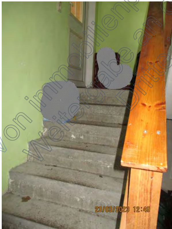
5.10 Treppenläufe, weitgehend ohne Belag und provisorisches Geländer, Beispiel
