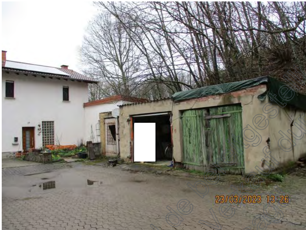
5.5 Rückseite, PKW-Garagen, Übersicht
