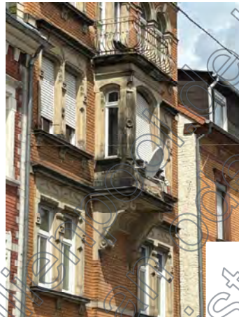
Erkervorbaue mit Balkonplatte
