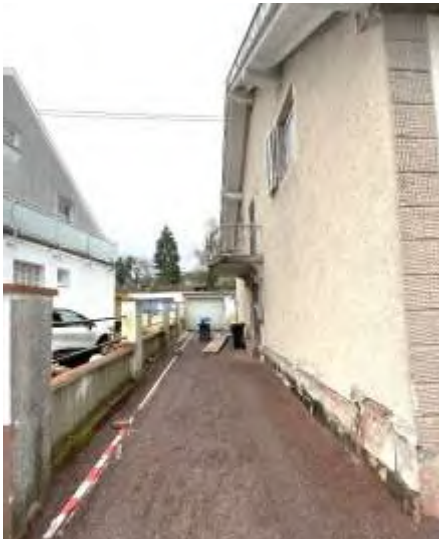
Unterbau für Zufahrtsbefestigung bereits vorhanden
