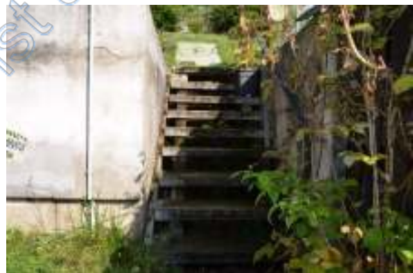
Außentreppe und Stützmauer exemplarisch
