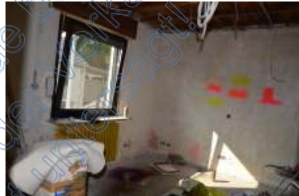
Raum im OG – nicht fertiggestellt
