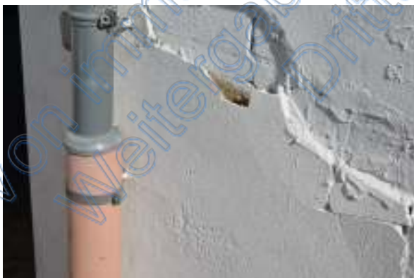
Fassade mit Putzschäden
