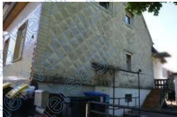
Giebelansicht – Fassade mit Faserzementplatten (vermutlich asbesthaltig) verfärbt und verschmutzt
