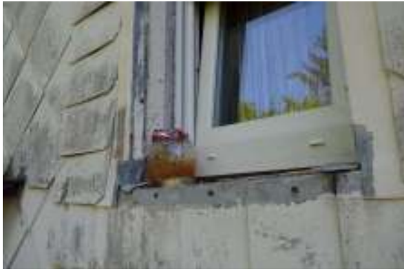
Fassade und fehlende Fensterbank sowie Fenster exemplarisch
