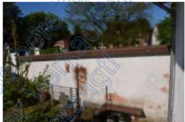
Seitenansicht Garage mit Putzschäden
