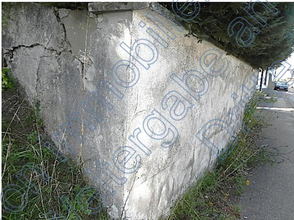
Feuchte/Putzschäden an Gelände-Stützwand
