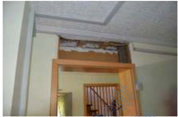
fehlende Bekleidung über Tür
