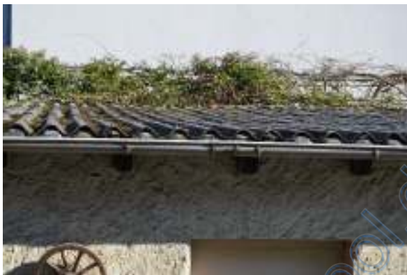
überalterte und vermooste Dacheindeckung
