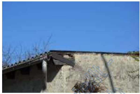
Fassade verfärbt und verschmutzt, schadhafte Dacheindeckung
