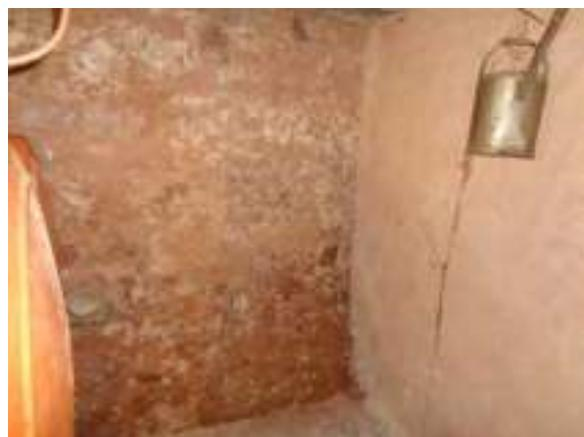
Feuchtespuren auf Betonboden
