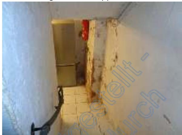
Detail Feuchteschäden KG-Flurbereich
