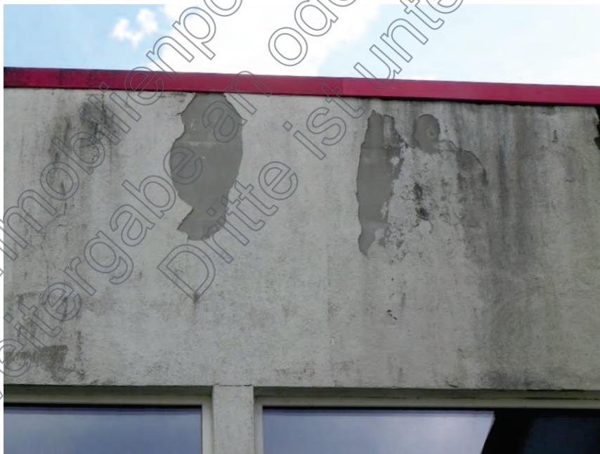
Beispiel erhebliche Attikaschäden West
