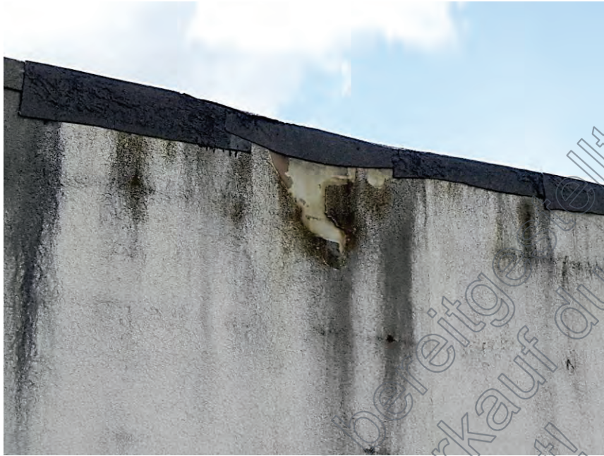
Detail Attika Nord mit Notabdichtung
