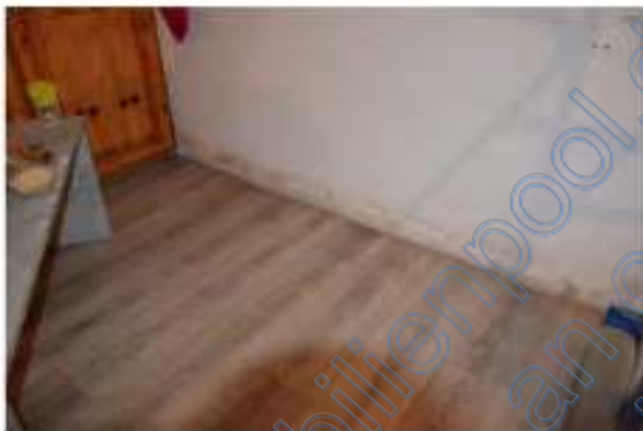
Feuchtigkeitsschaden in Einliegerwohnung – fehlende Sockelleisten
