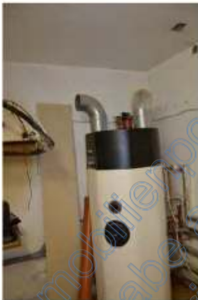
Wärmepumpe für Warmwasseraufbereitung
