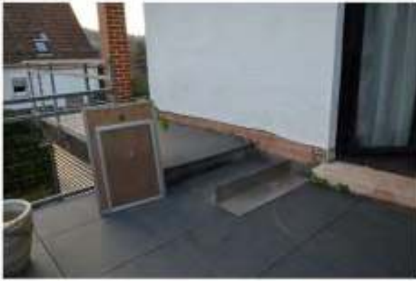
schadhafter Belag auf Terrasse und fehlender Sockel
