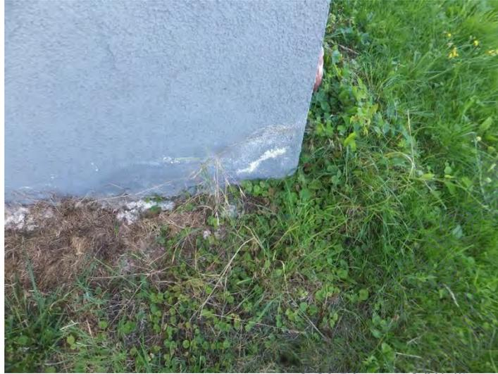
Bild 11: Beispiel für Feuchtigkeitsschaden am Sockel Bergstr. 3a
