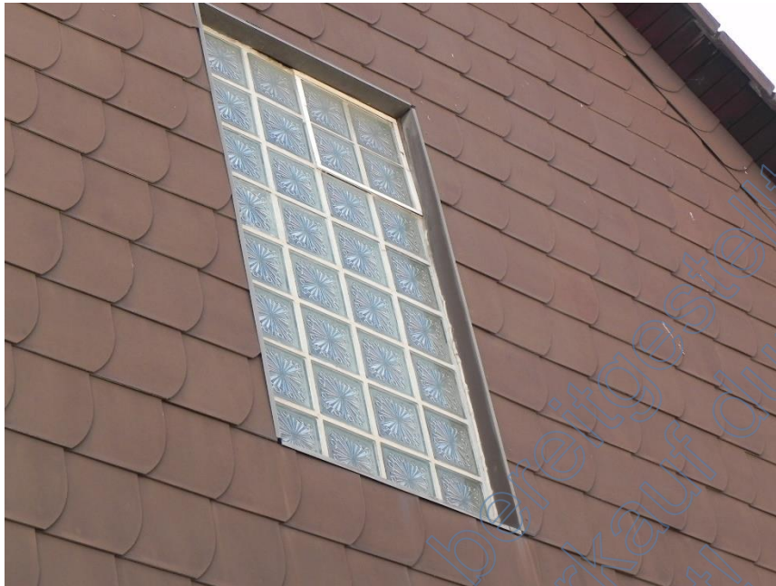
Glasbausteine Giebel Ost Dachgeschoss
