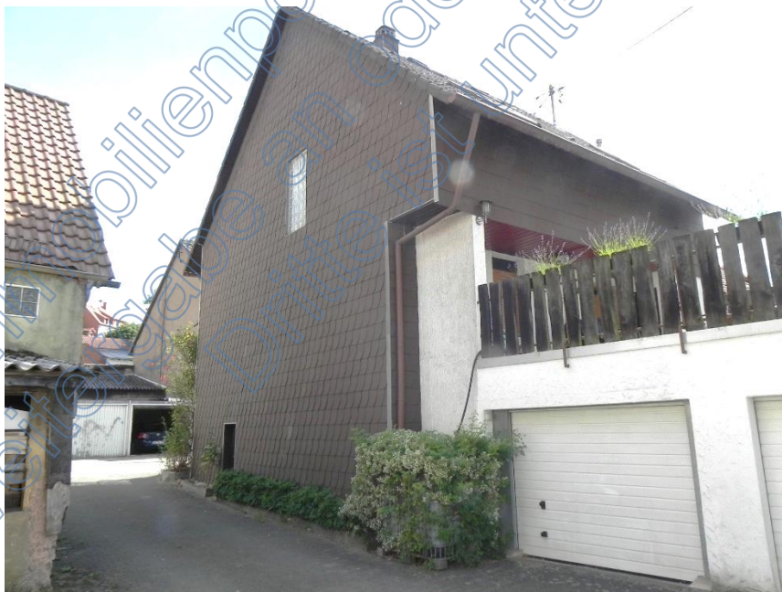
Ansicht Giebel Ost mit Doppelgarage
