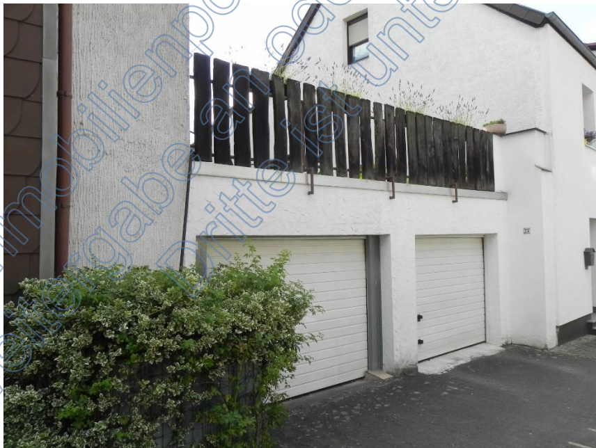
Doppelgarage grenzständig zu nördlichem Anlieger
