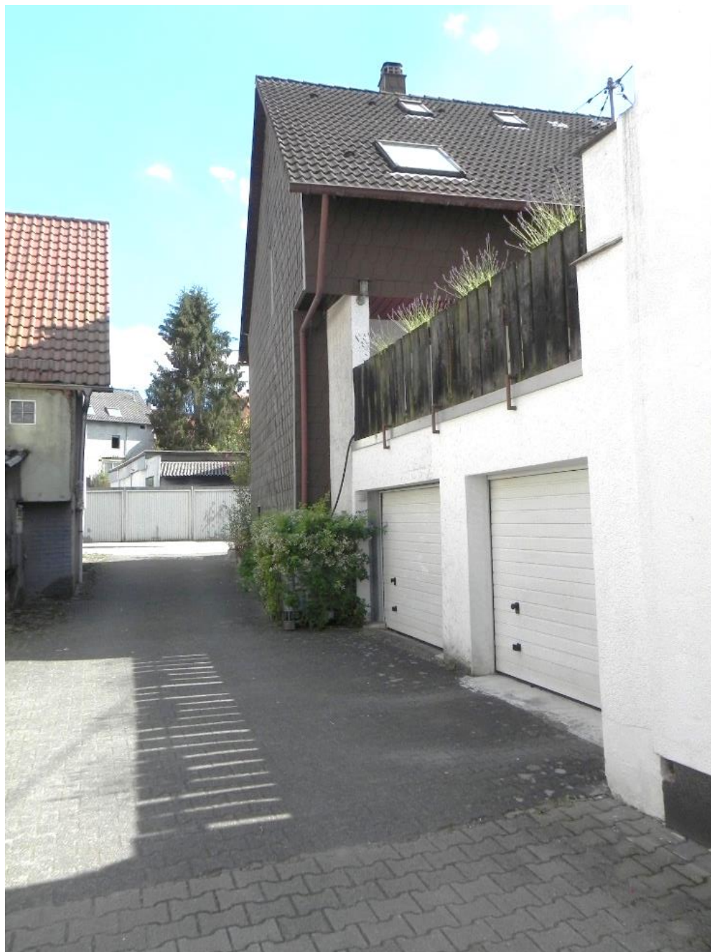
Ansicht von Norden aus Seitenstrasse
