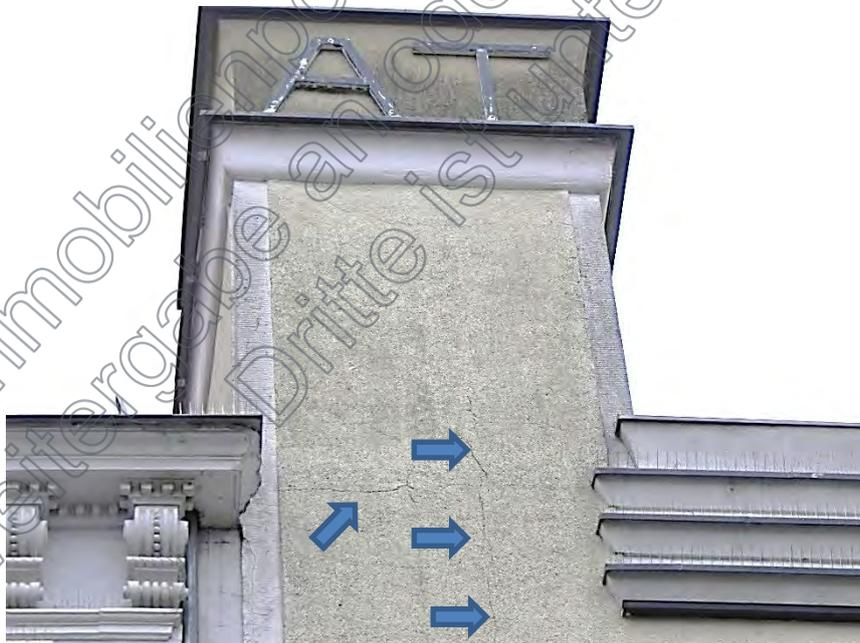
Detail Fassade Dachaufbau, Putzrisse erkennbar
