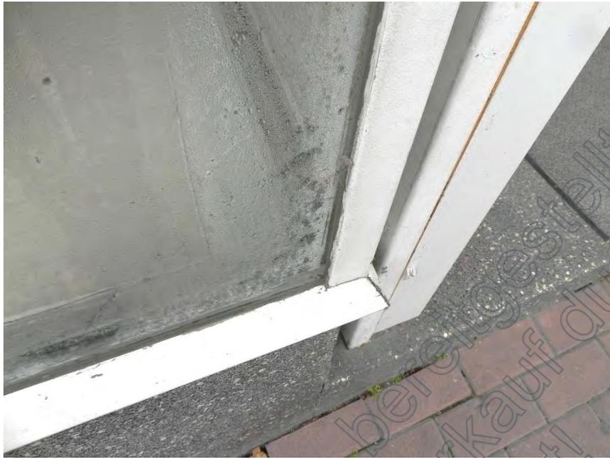
Detail Schaufensteranlage West, tlw. einfachverglast
