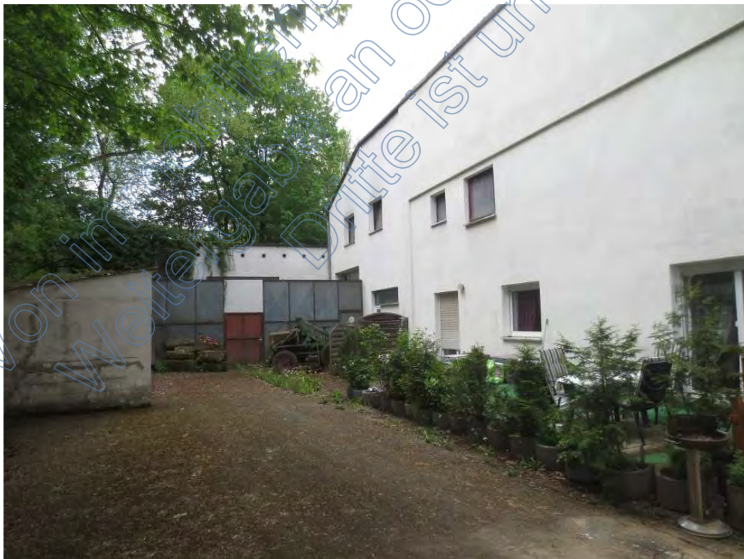
5.8 Rückseite, Terrassen der EG-Wohnungen, Nebengebäude, Übersicht
