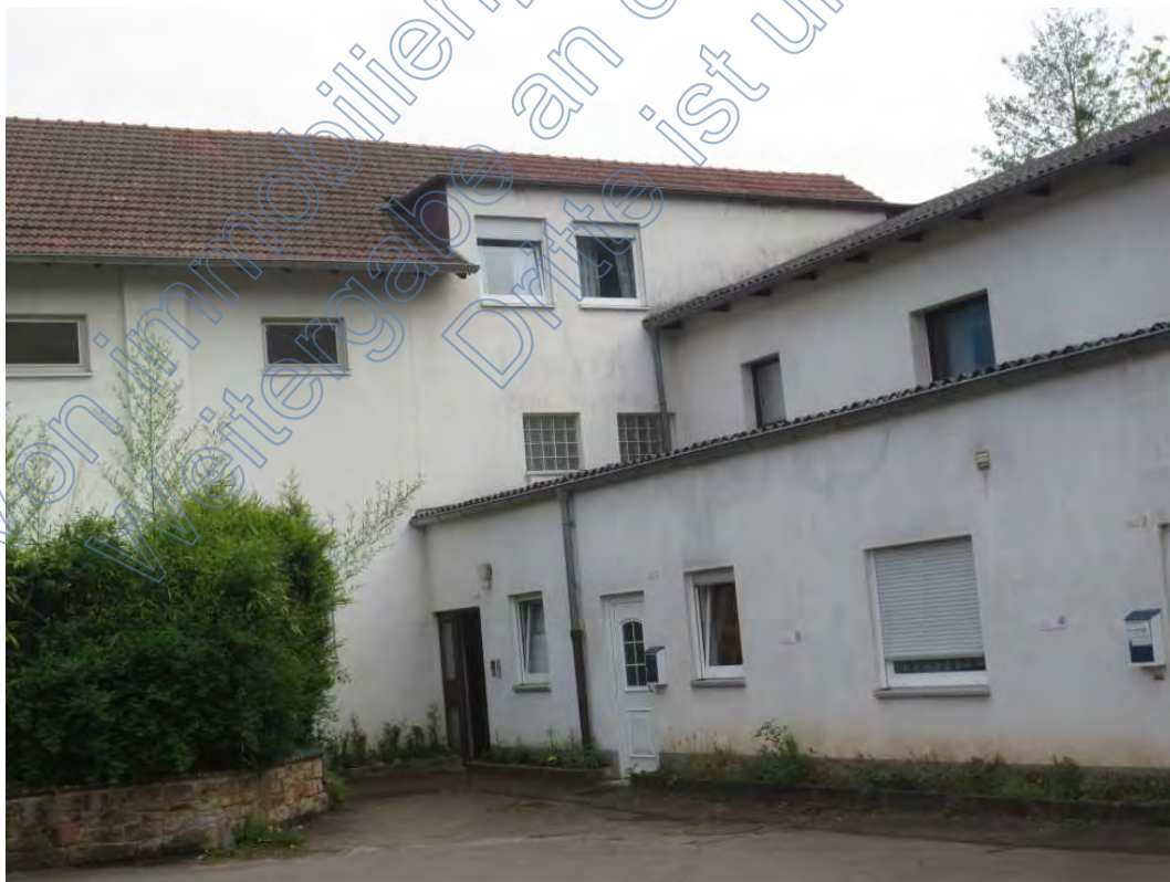
5.2 Hauseingang Nr. 20a 5 mit Treppenzugang
