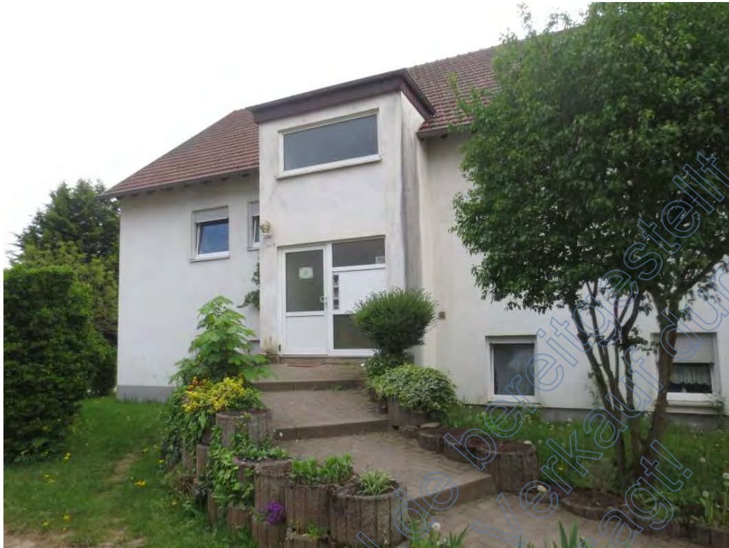
5.3 Hauseingang Nr. 20a 4, Übersicht
