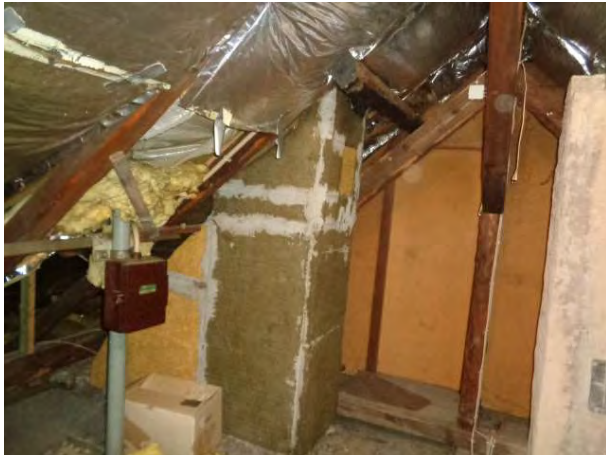
Im Speicher Schornstein gedämmt
