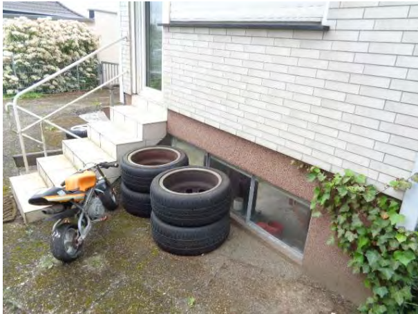
Rückseitiger EG-Ausgang mit Treppe
