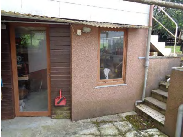
Außenzugang KG-Werkraum (Anbaubereich)
