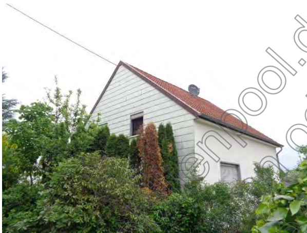
Linke Giebelansicht Südwesten)
