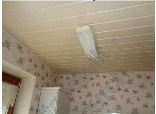
Paneele-Deckenverkleidung
