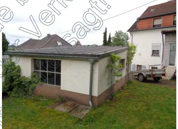
Rückseite Garage; erneuerter Blechdeckung
