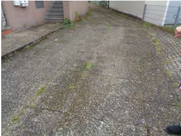
Befestigung aus Betonplatten u. -pflaster
