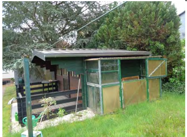
Holz-Gartenhaus mit erneuerter Dachdeckung
