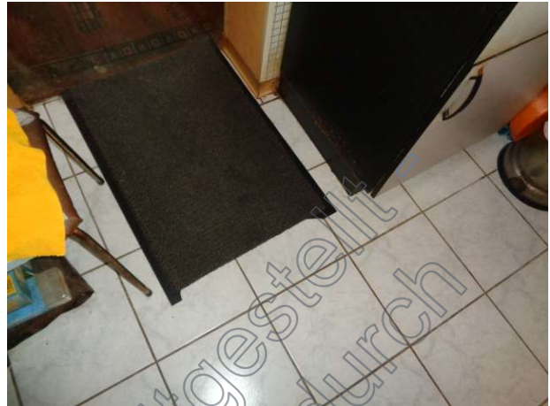
Detail Bodenfliesen Küche
