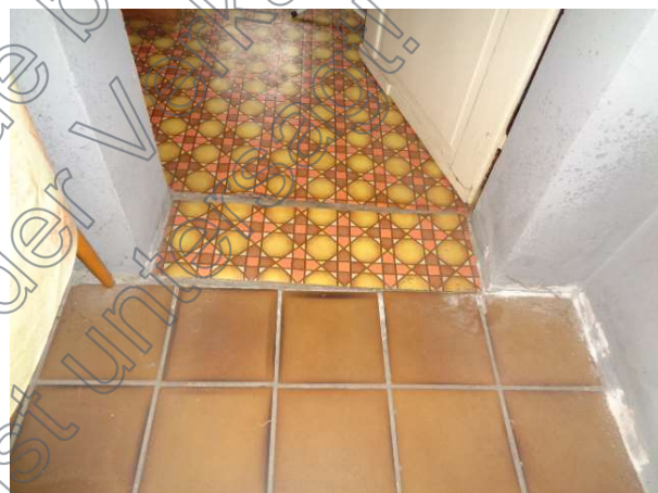
Detail Bodenbeläge Fliesen / PVC
