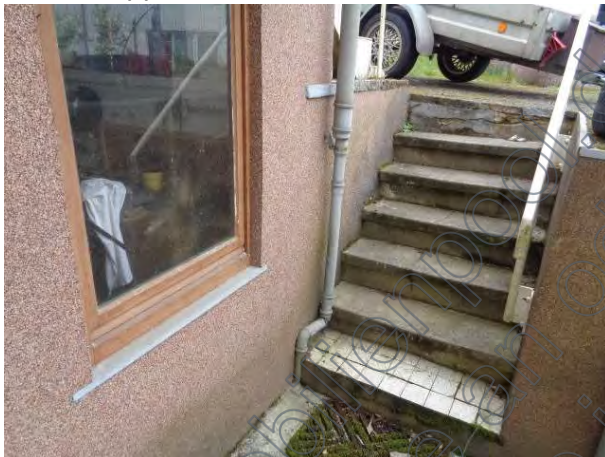
Außentreppe zum unteren Hofbereich
