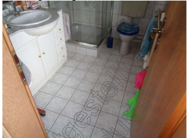
DG-Bad gem. Angaben Einbau ca. 1996
