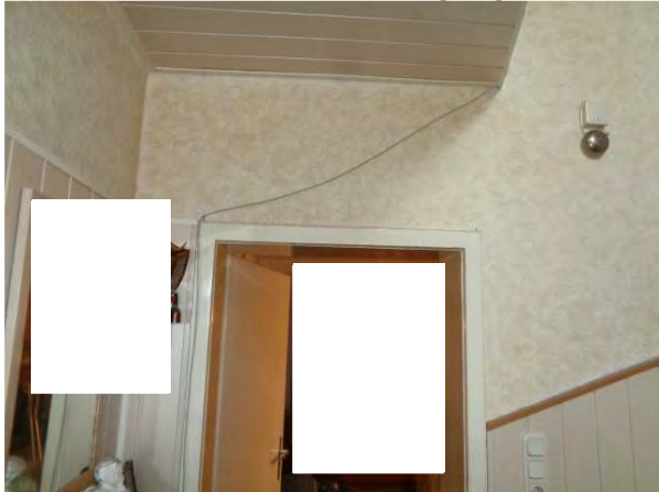
Provisorische SAT-Kabelverlegung DG/ EG
