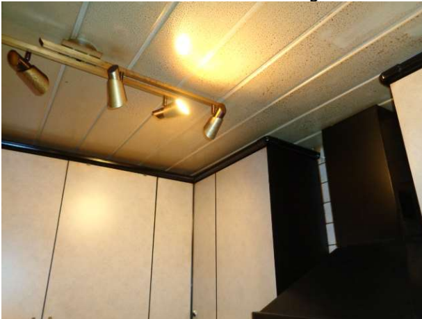
Detail Paneele-Deckenverkleidung
