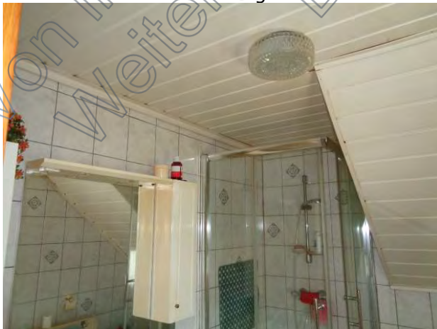
Paneele-Deckenverkleidung im Bad
