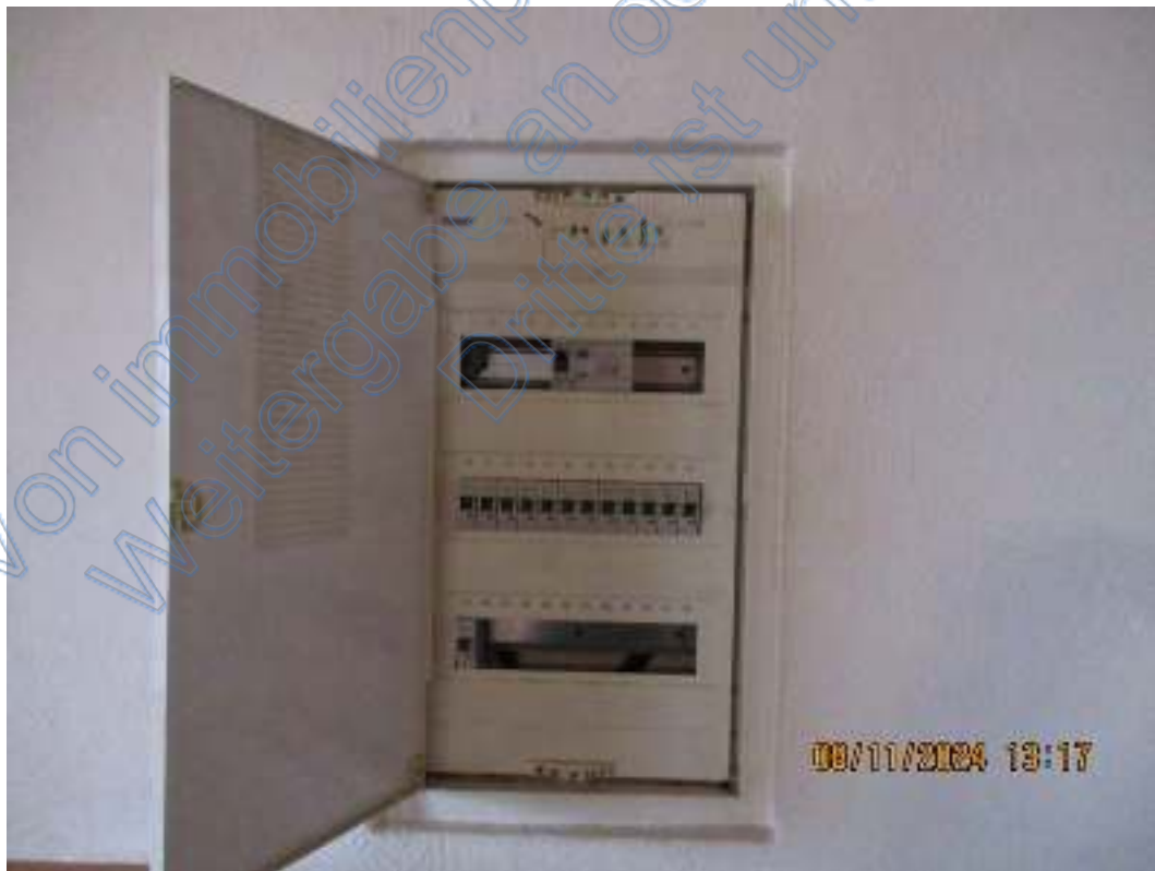
5.6 Elektrounterverteilung, Beispiel
