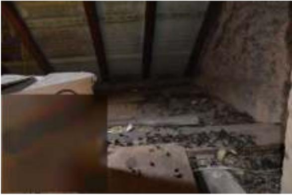
Dämmung oberste Geschossdecke schadhaft
