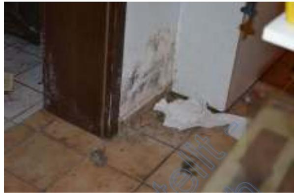
Putz- und Feuchtigkeitsschäden an Innenwand sowie schadhafte Türen/Türarten
