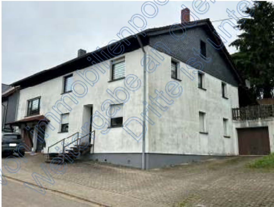
STRASSESEITE MIT ANGEBAUTER AUSSENGARAGE
