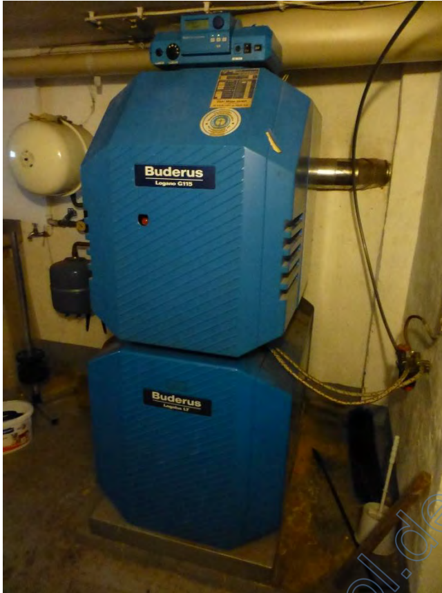
Öl-Heizungsanlage
