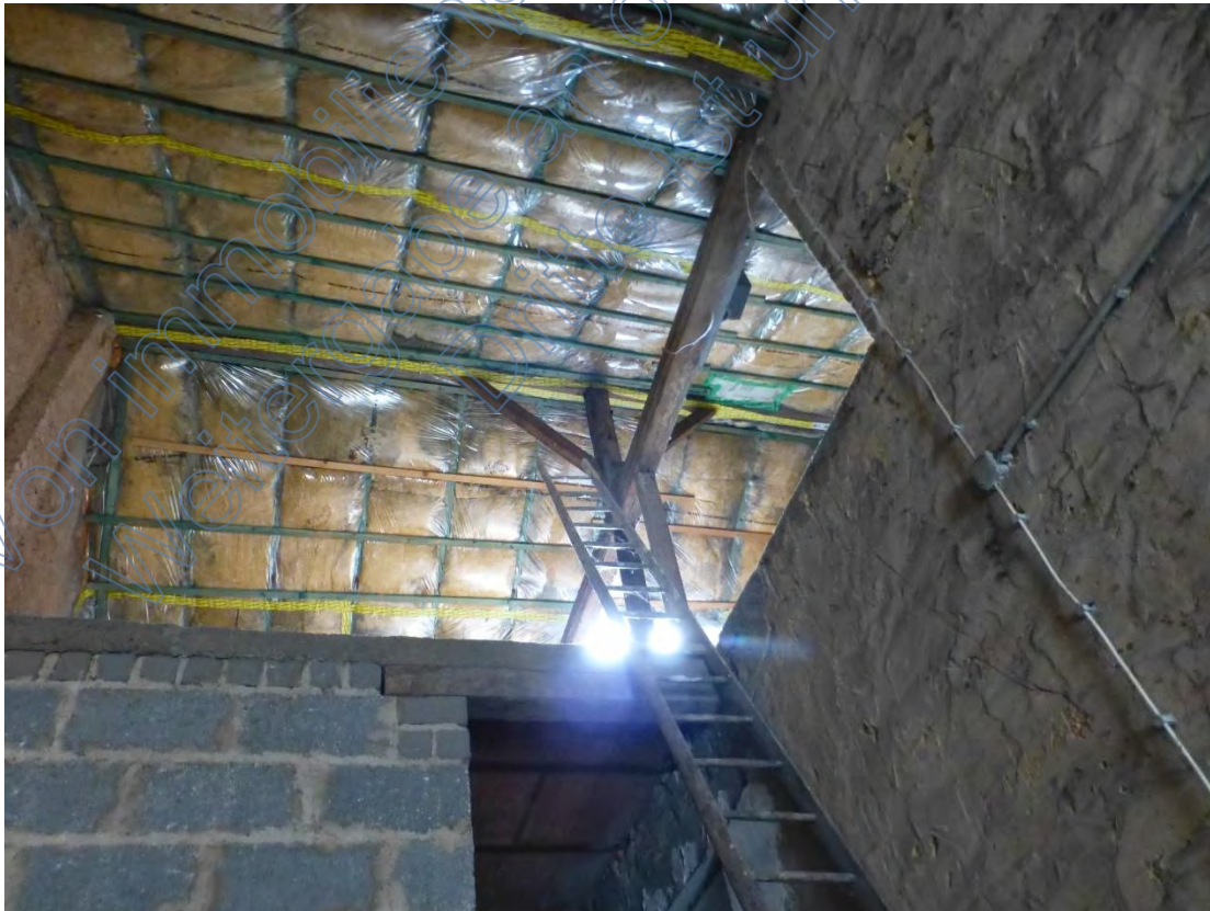
Rechter Gebäudebereich (nicht ausgebaut)
