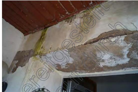
Bild 22: Starke Feuchteschäden Hauseingangspodest
