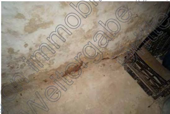
Bild 51: Feuchteschäden Kellermauerwerk
