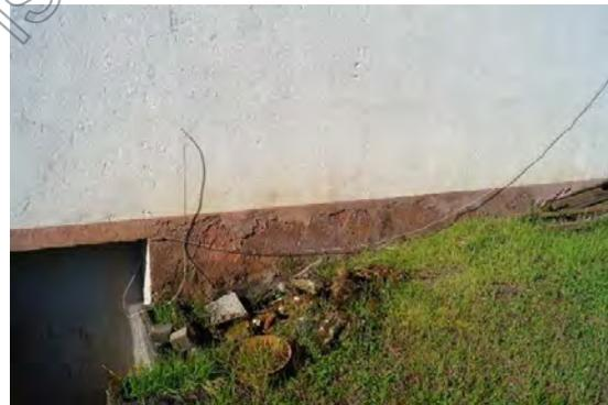
Bild 8: Putzschäden Sockelbereich
