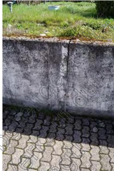
Bild 14: Betonschäden Stützmauer (exemplarisch)
