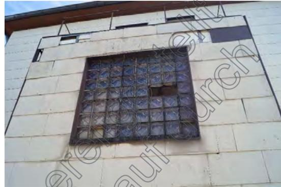
Bild 17: Schadhafte Verkleidung
