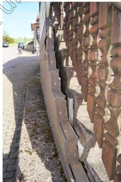
Bild 16: Schadhafte Verkleidung
