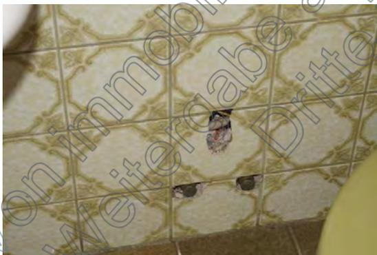
Bild 43: Fliesenschäden Bad OG
