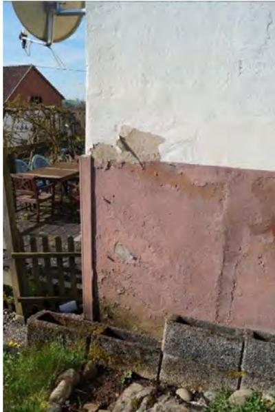
Bild 9: Putzschäden Sockelbereich
