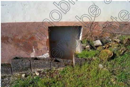
Bild 7: Putzschäden Sockelbereich
