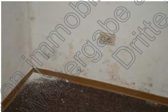
Bild 39: Feuchteschäden, Schimmelbildung
