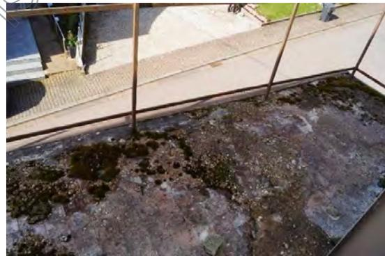
Bild 19: Schadhafte Verkleidung
