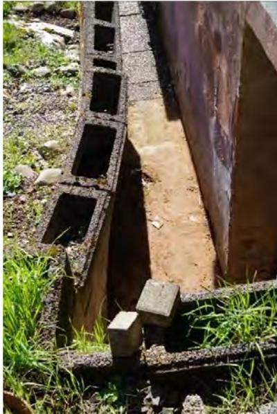
Bild 13: Abgekippte Stützmauer (Kellereingang Rückfront)
