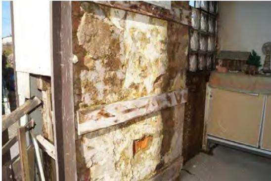
Bild 21: Starke Feuchteschäden Hauseingangspodest
