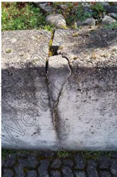
Bild 15: Betonschäden Stützmauer (exemplarisch)
