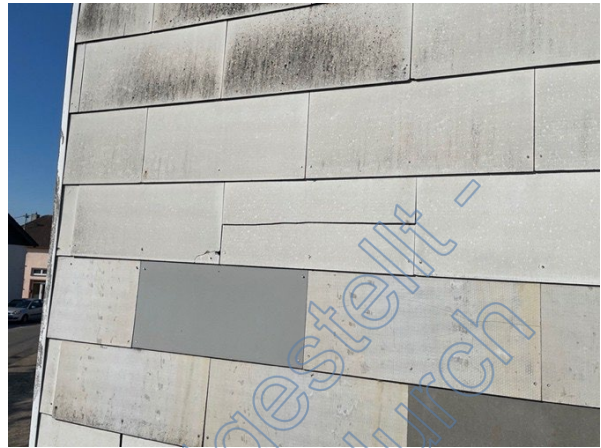
Fassadenplatten gebrochen
