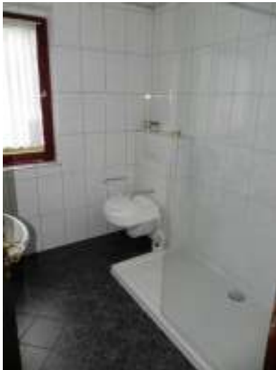
Modernisiertes Bad Altbau EG
