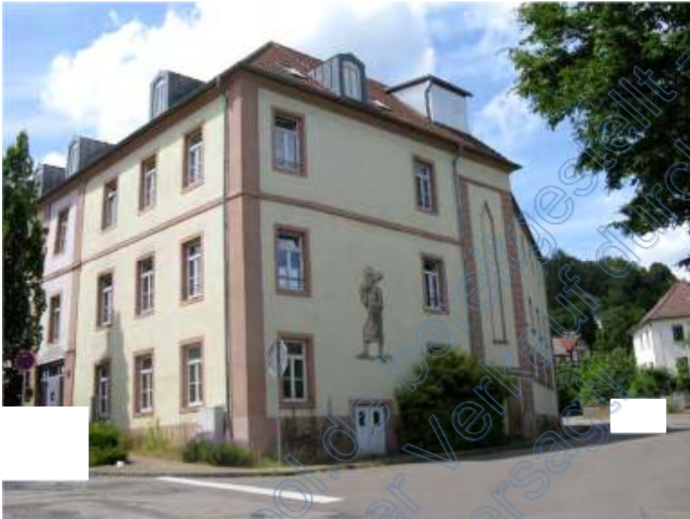
Straßenansicht (Ecke Schloßbergstraße - Klosterweg)
