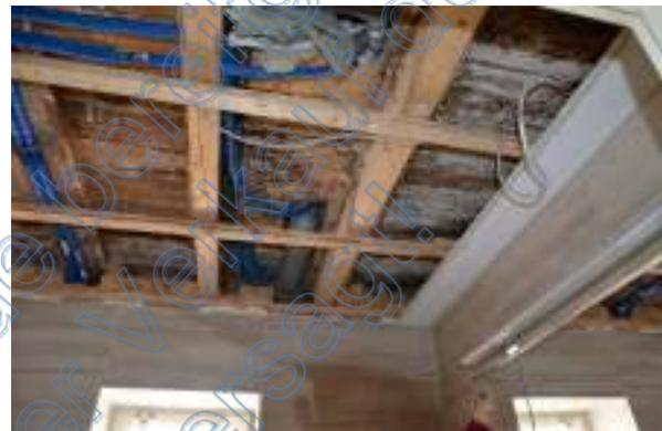
fehlende Decke im EG-Bad aufgrund Undichtigkeit im DG-Bad
