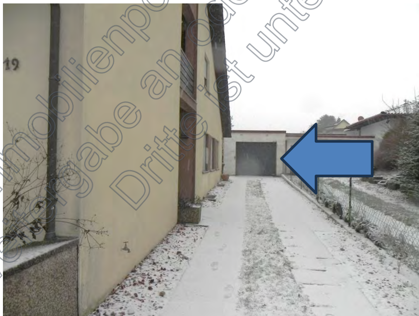
Zufahrt zur Garage
