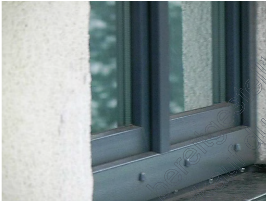
Beispiel modernisierte Fenster, unterstellt alle modernisiert
