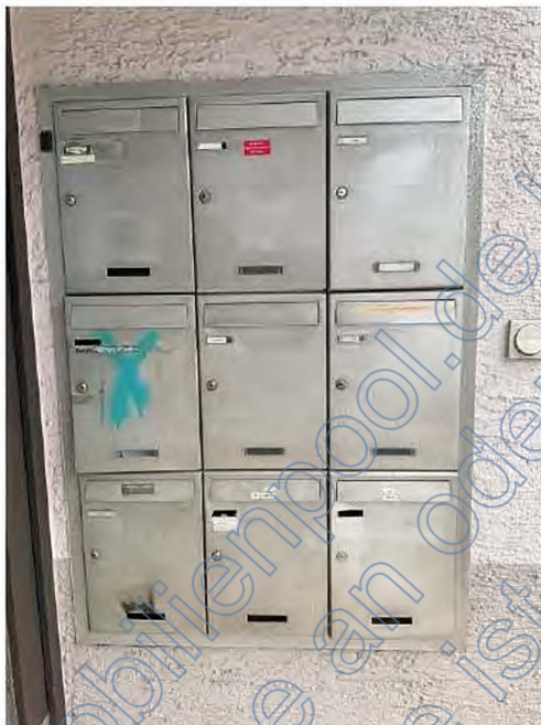
Eingangs- flur (rechts)
