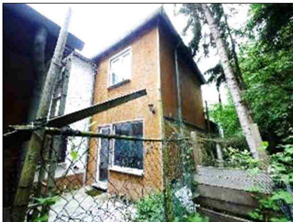
Bild 31: nicht genehmigte Anbauten an der Gebäuderückseite
