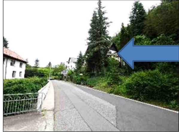
Bild 2: Blick in die Erschließungsstraße mit Bewertungsobjekt
