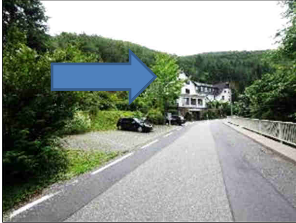
Bild 1: Blick in die Erschließungsstraße mit Bewertungsobjekt
