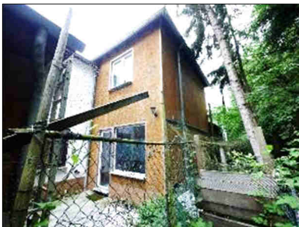
Bild 31: nicht genehmigte Anbauten an der Gebäuderückseite
