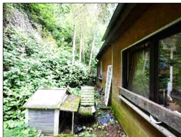
Bild 32: nicht genehmigte Anbauten an der Gebäuderückseite
