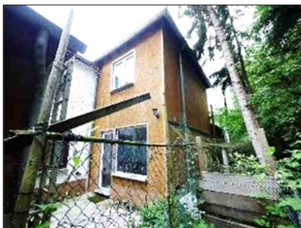
Bild 31: nicht genehmigte Anbauten an der Gebäuderückseite
