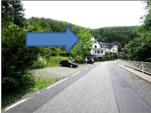
Bild 1: Blick in die Erschließungsstraße mit Bewertungsobjekt
