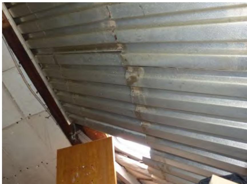
Trapezbleche als Unterkonstruktion der Dacheindeckung
