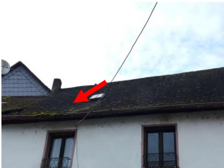
Die Dachkonstruktion hängt durch; vermutlich gebrochene Sparrenlage
