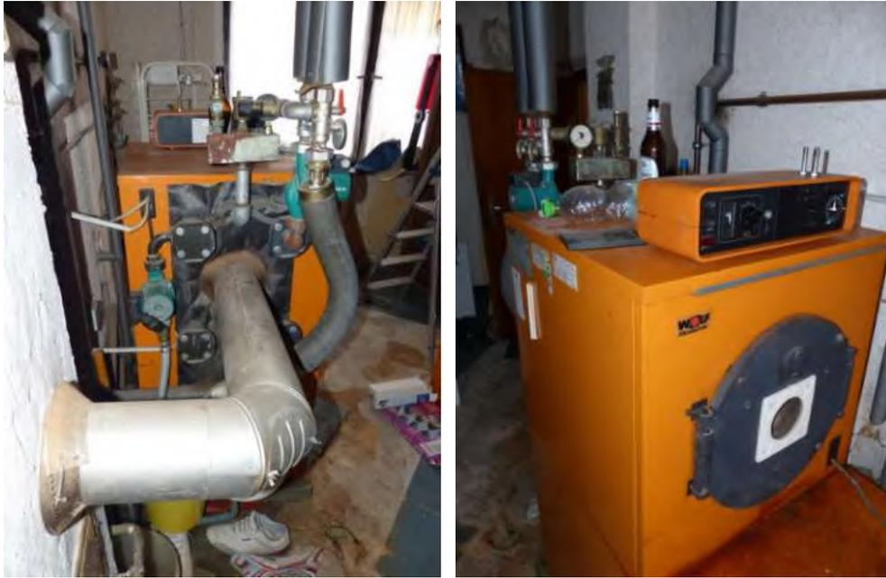
Heizungsanlage (fehlender Brenner u.a.) defekt und überaltert
