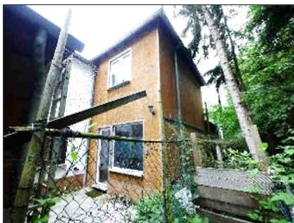
Bild 31: nicht genehmigte Anbauten an der Gebäuderückseite
