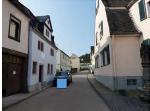
Foto: Umliegende Bebauung
