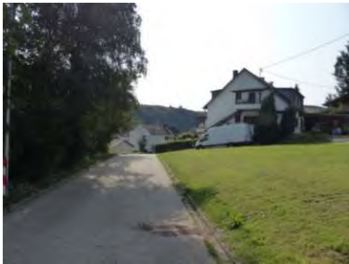
Foto: Umliegende Bebauung
