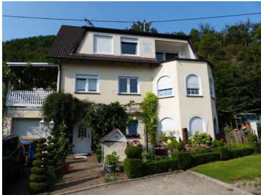
Vorderansicht mit Hauseingang
