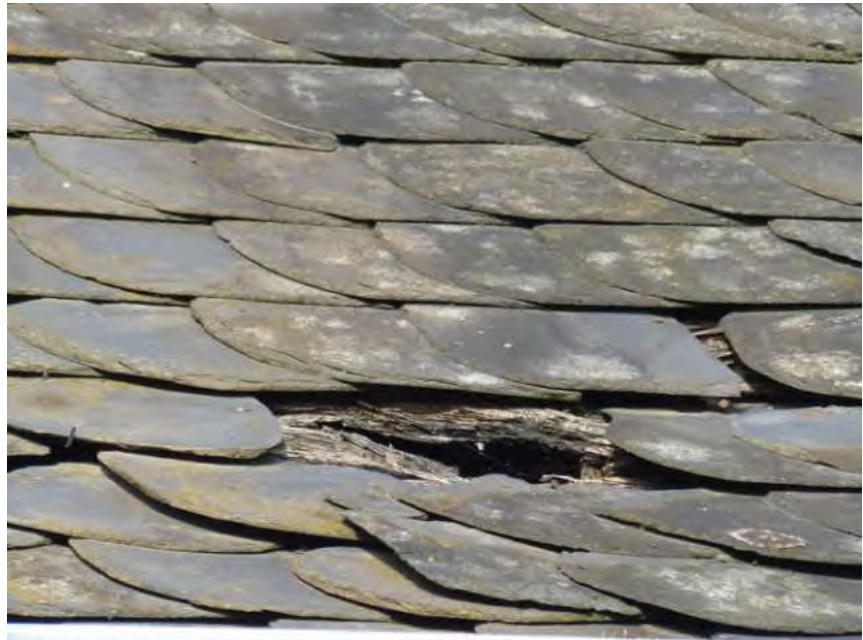
Dachstuhl/Holzschalung faul
