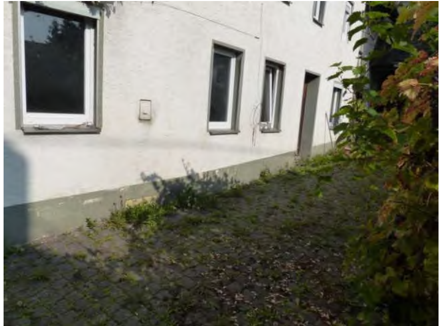
Zugang zum Objekt
