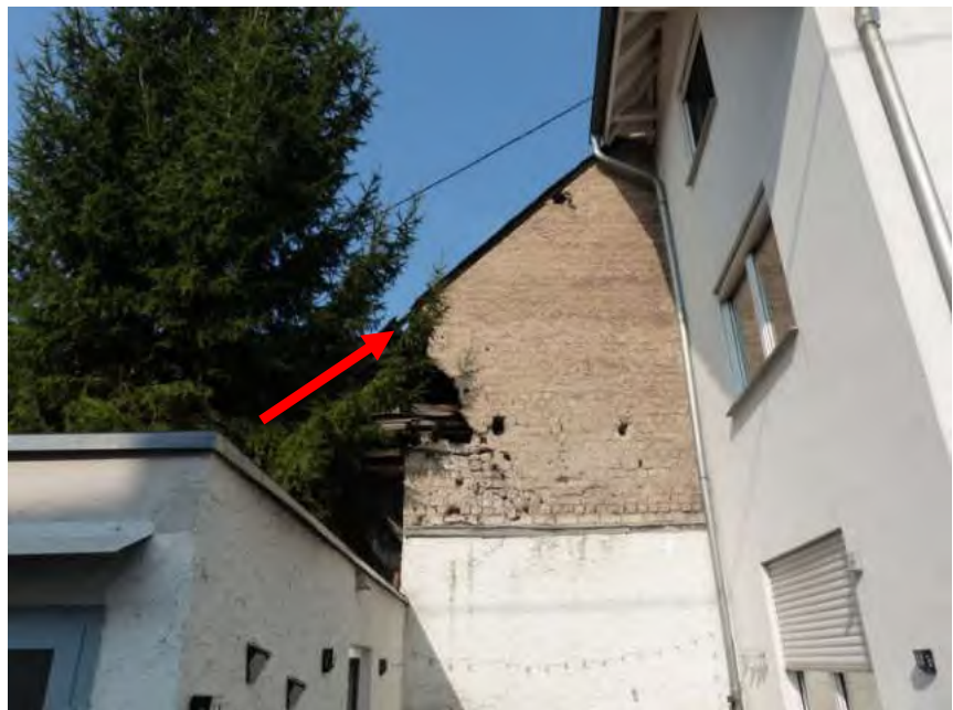
Seitenansicht ehemalige Scheune
