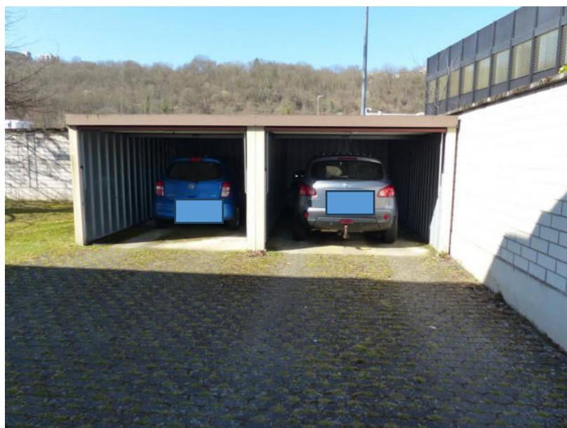
Doppelgarage in Metallkonstruktion
