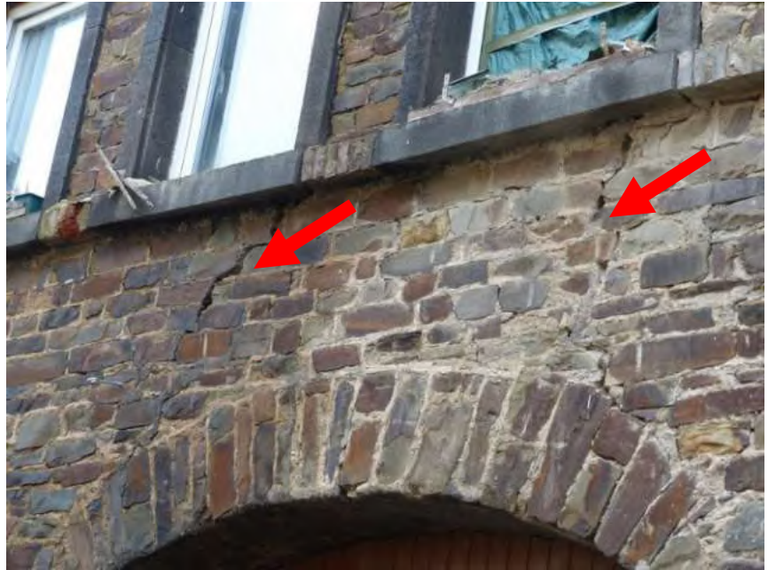
Mauerwerksrisse (Ursache vermutlich auf äußeren Einflüsse)
