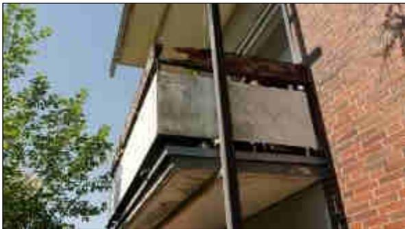
Bild 51: Unterhaltungstau/Schäden (Beispiel)
