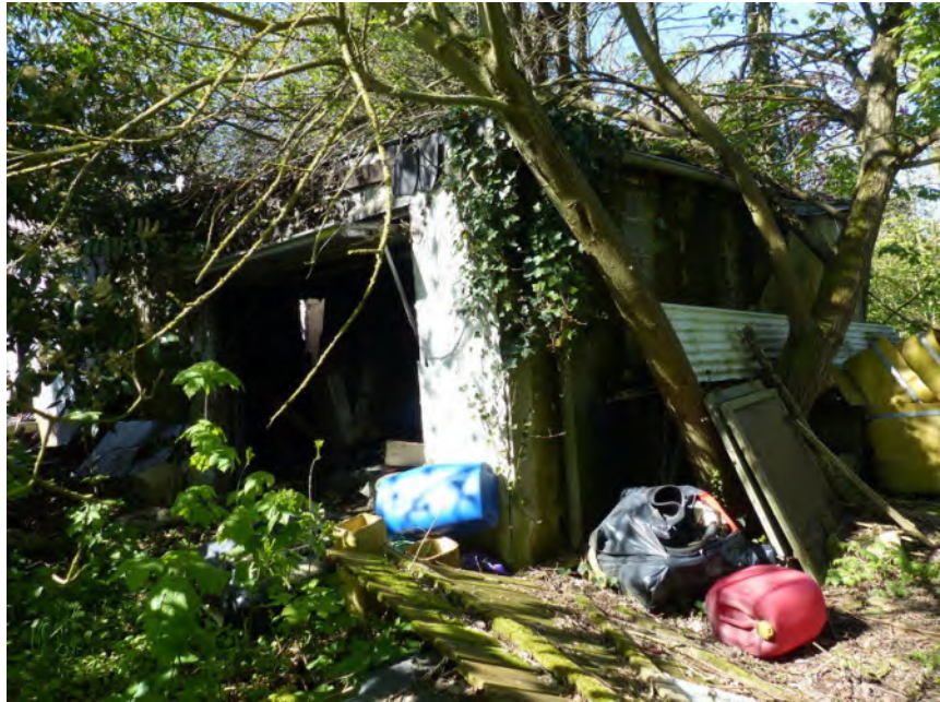
Abrissobjekt ehemalige Garage
