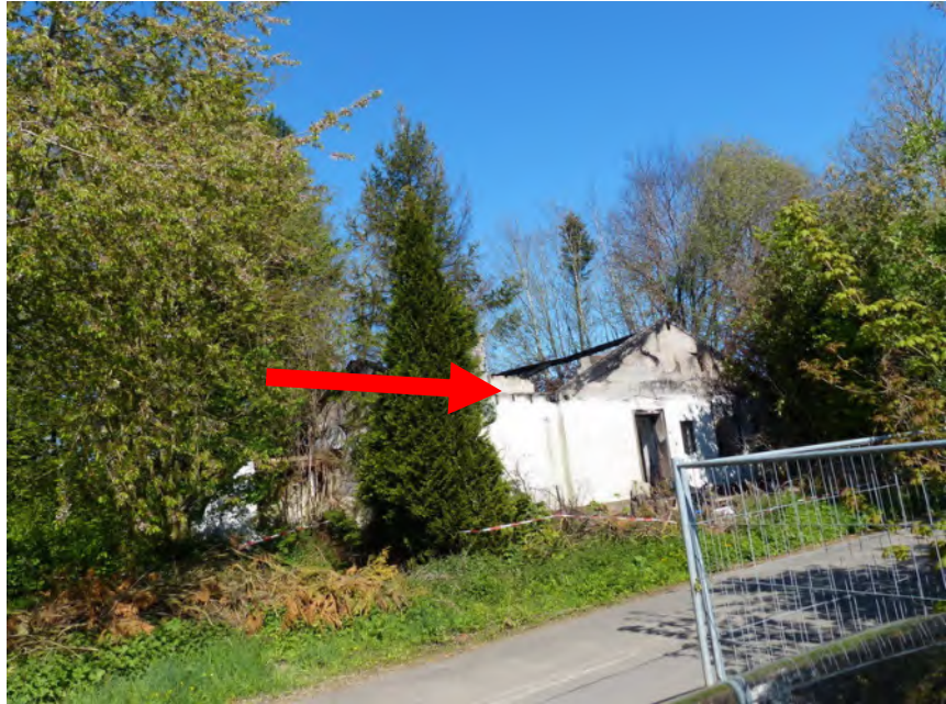
Flurstück 4/1 mit Bestandsbebauung nach Brandschaden
