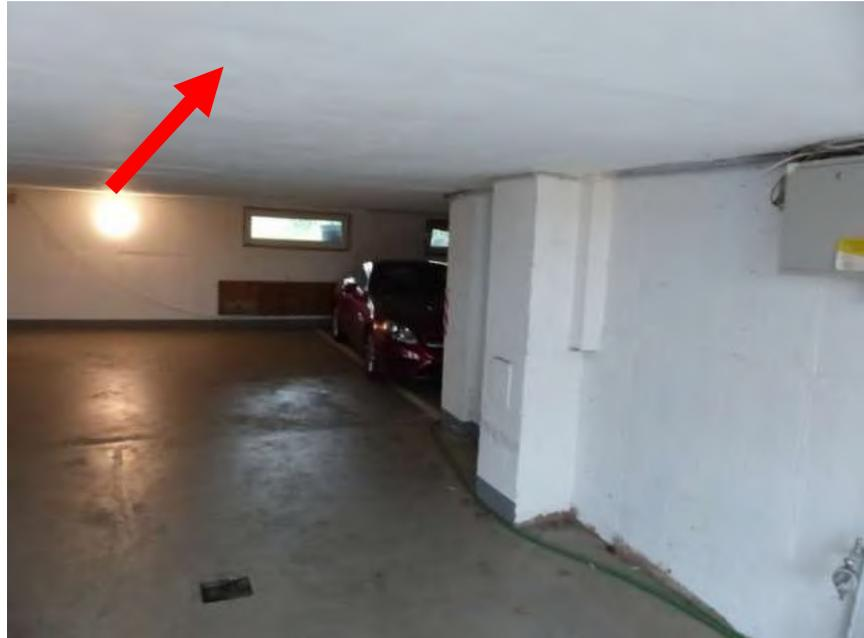
Deckenfläche mit Styropor gedämmt (Brandlast).
