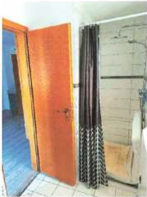
Bild 29 Das Bad im Obergeschoss.
