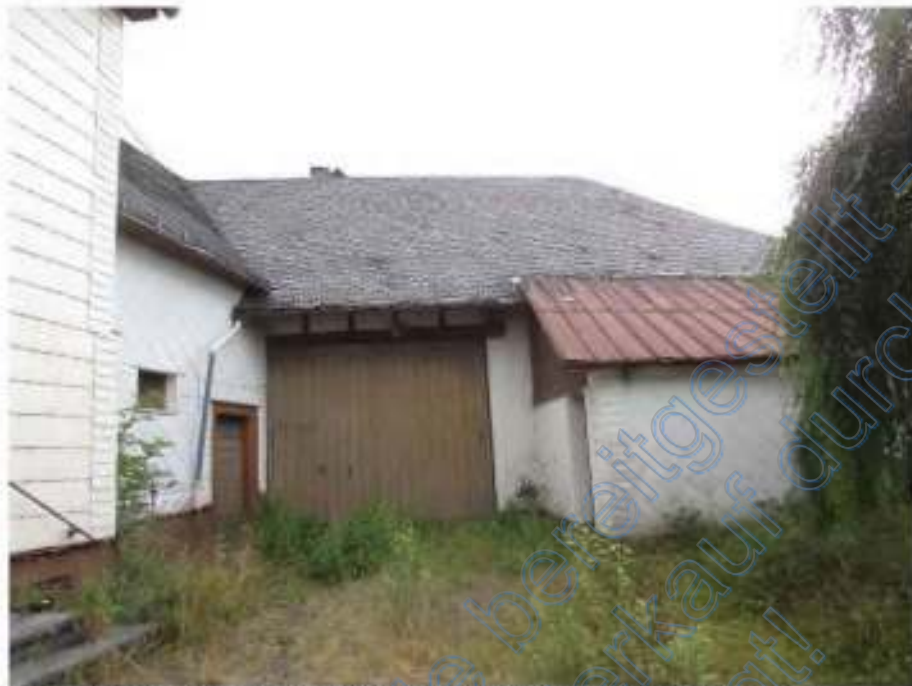
Foto 5: Stall-/Scheunengebäude mit Pultdachanbau, Hofansicht
