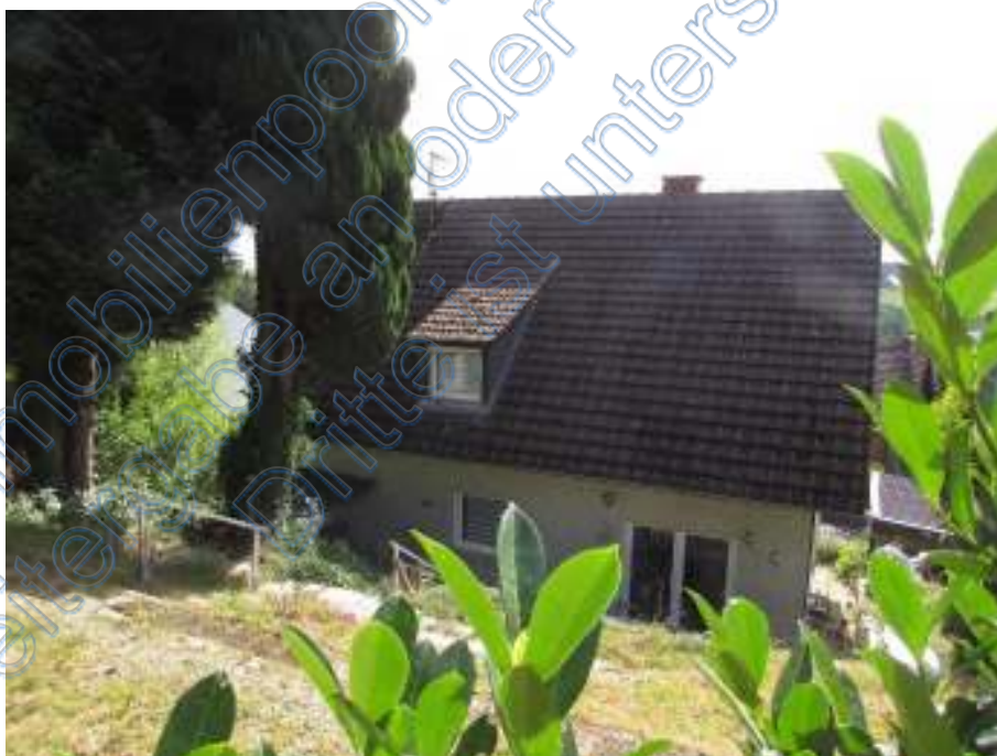
Foto 4: Wohnhaus, rückwärtige Ansicht
