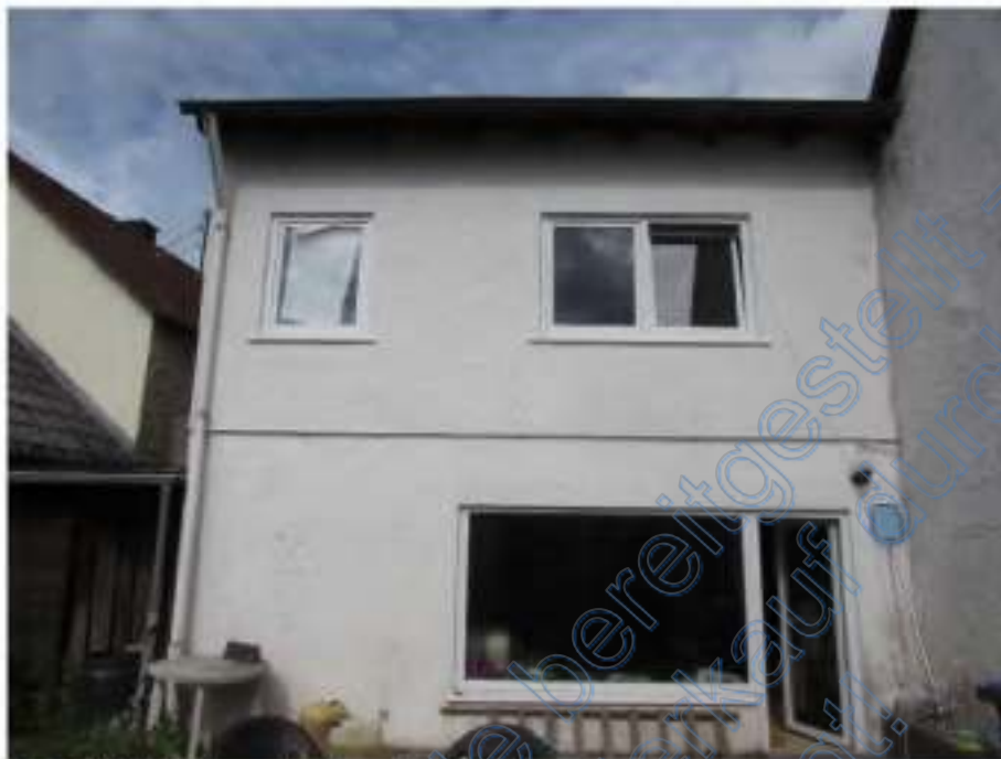
Foto 9: Wohnhaus-Anbau, rückwärtige Ansicht
