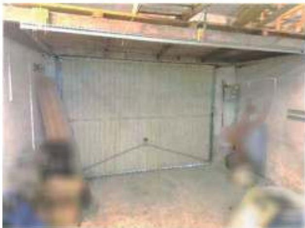
Bild 9 Blick in die Garage.
