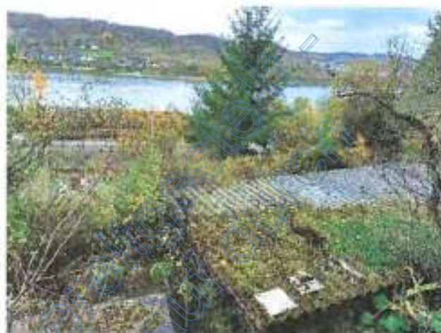
Bild 50 Blick vom Hanggrundstück zum Dachbereich des hinteren Gebäudeteils und Richtung Rhein.
