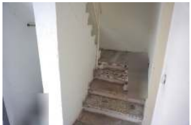
Treppe zum Obergeschoss im vorderen Wohngebäudeteil
