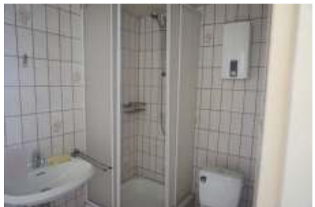
Bad im Erdgeschoss des hinteren Wohngebäudeteils
