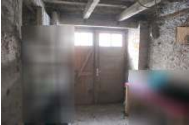
Garage im Erdgeschoss des hinteren Wohngebäudeteils
