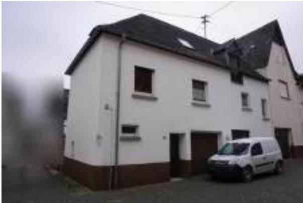
straßenseitige Ansicht von Norden auf beide Wohngebäudeteile
