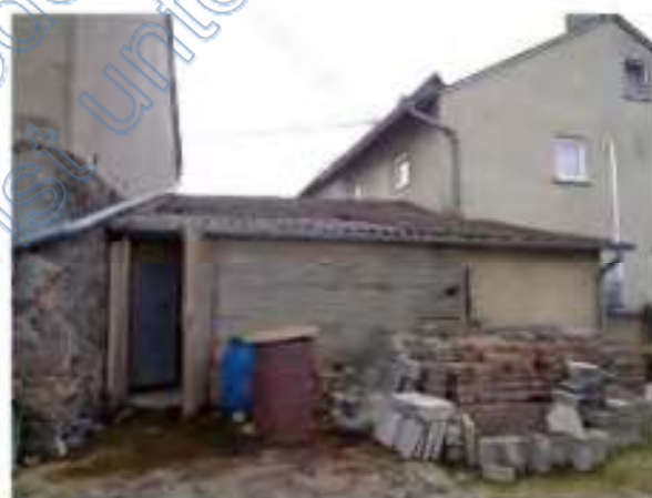
Bild 29 Gemeinschaftseigentum, Nebengebäude 2, von dem Flurstück 2/2 aus betrachtet
