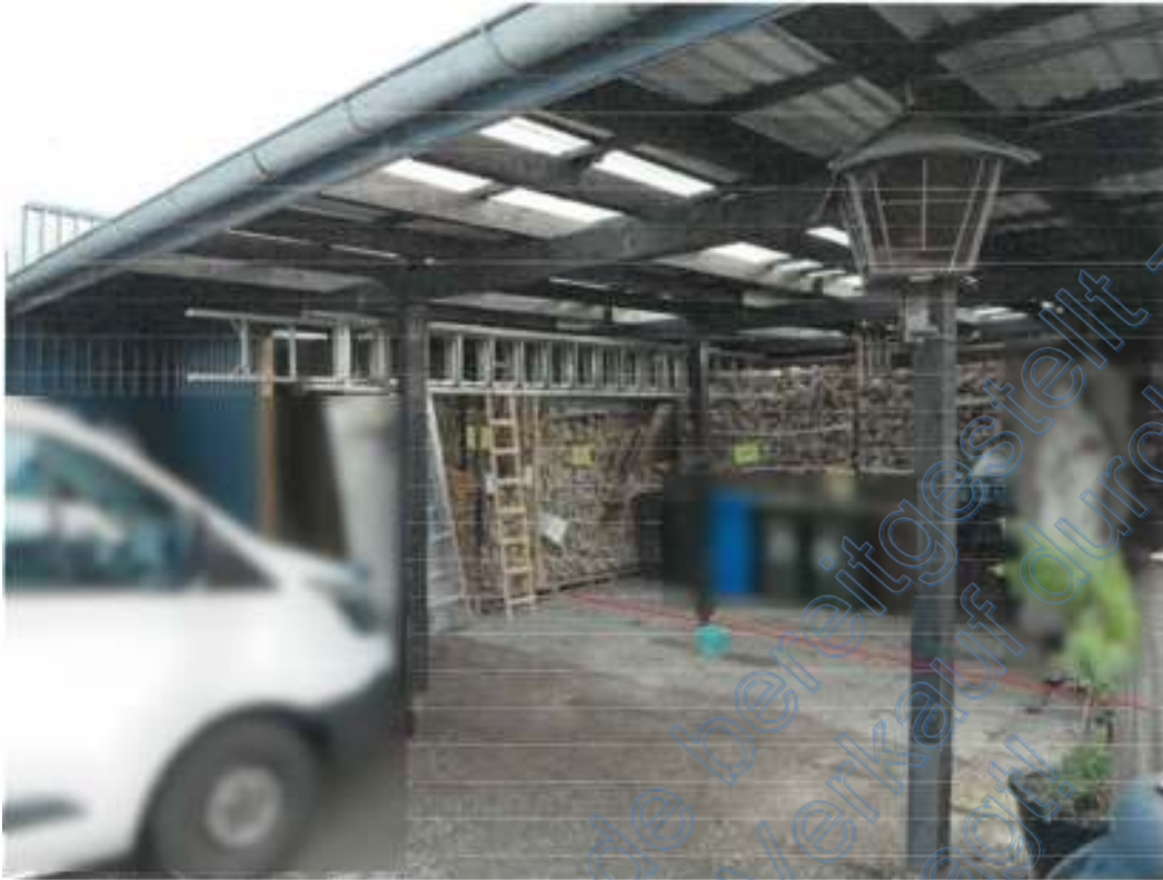
5 an Halle angebaute Überdachung, etwaiger Grenzverlauf rot markiert
